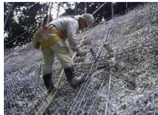
⑤2段目鉄筋、アンカー設置
