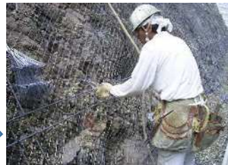
④RTフレーム設置
