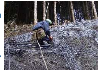
⑥モルタル、ダレ防止補助網設
