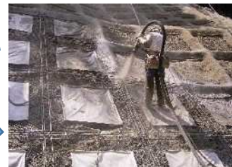
⑧法枠モルタル吹付
