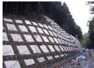
⑦枠内養生シート設
