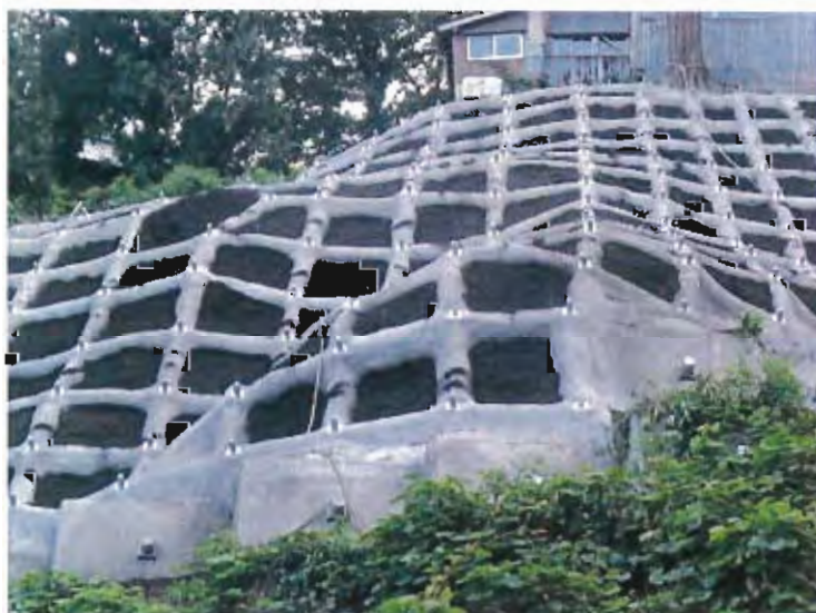
ロックボルト併用時施工例-3
