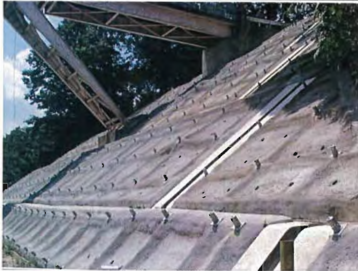
ロックボルト併用時施工例-1
