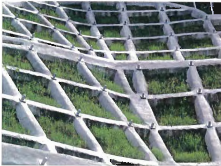
ロックボルト併用時施工例-2
