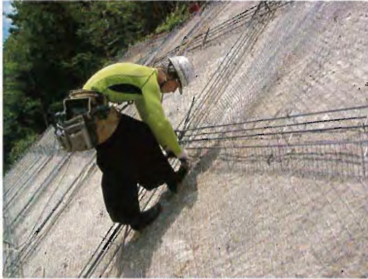
法枠・鉄筋組立
